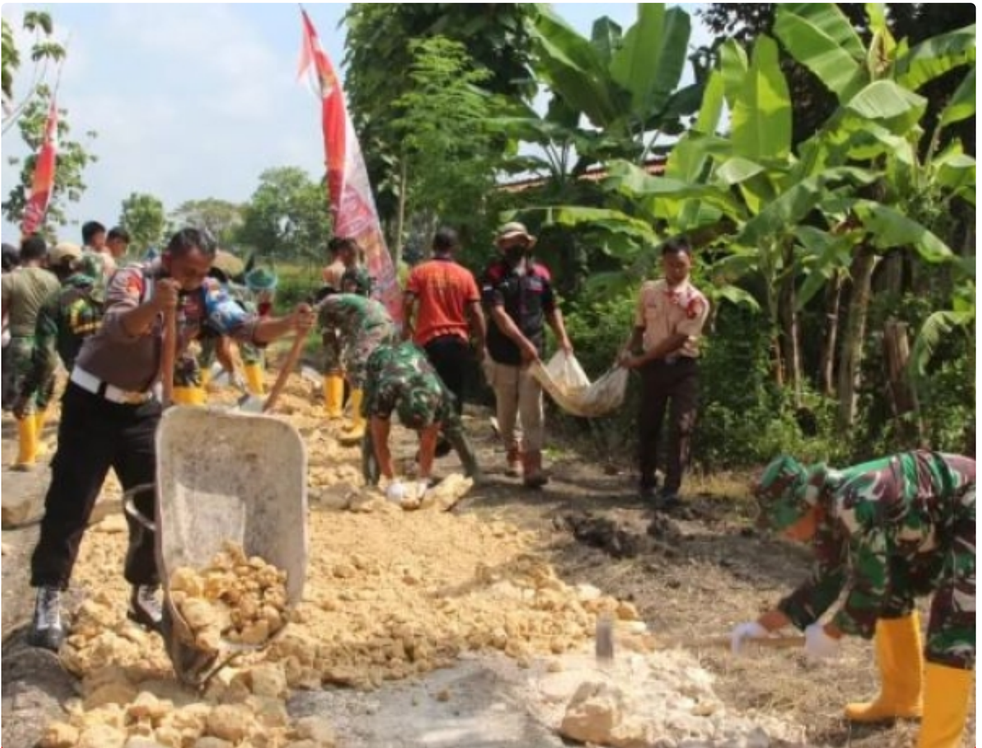
Foto Giat: TNI-Polri Laksanakan Pembangunan Jalan di Lokasi TMMD Reg Kodim Blora. Rabu, (25/05/2022).
